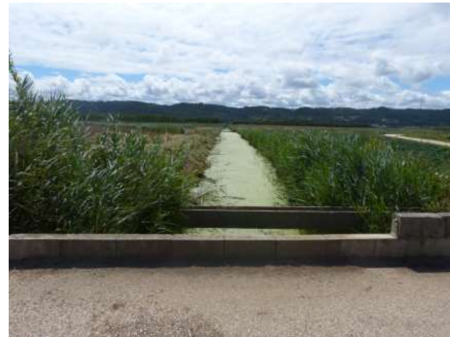
Vala principal de drenagem
